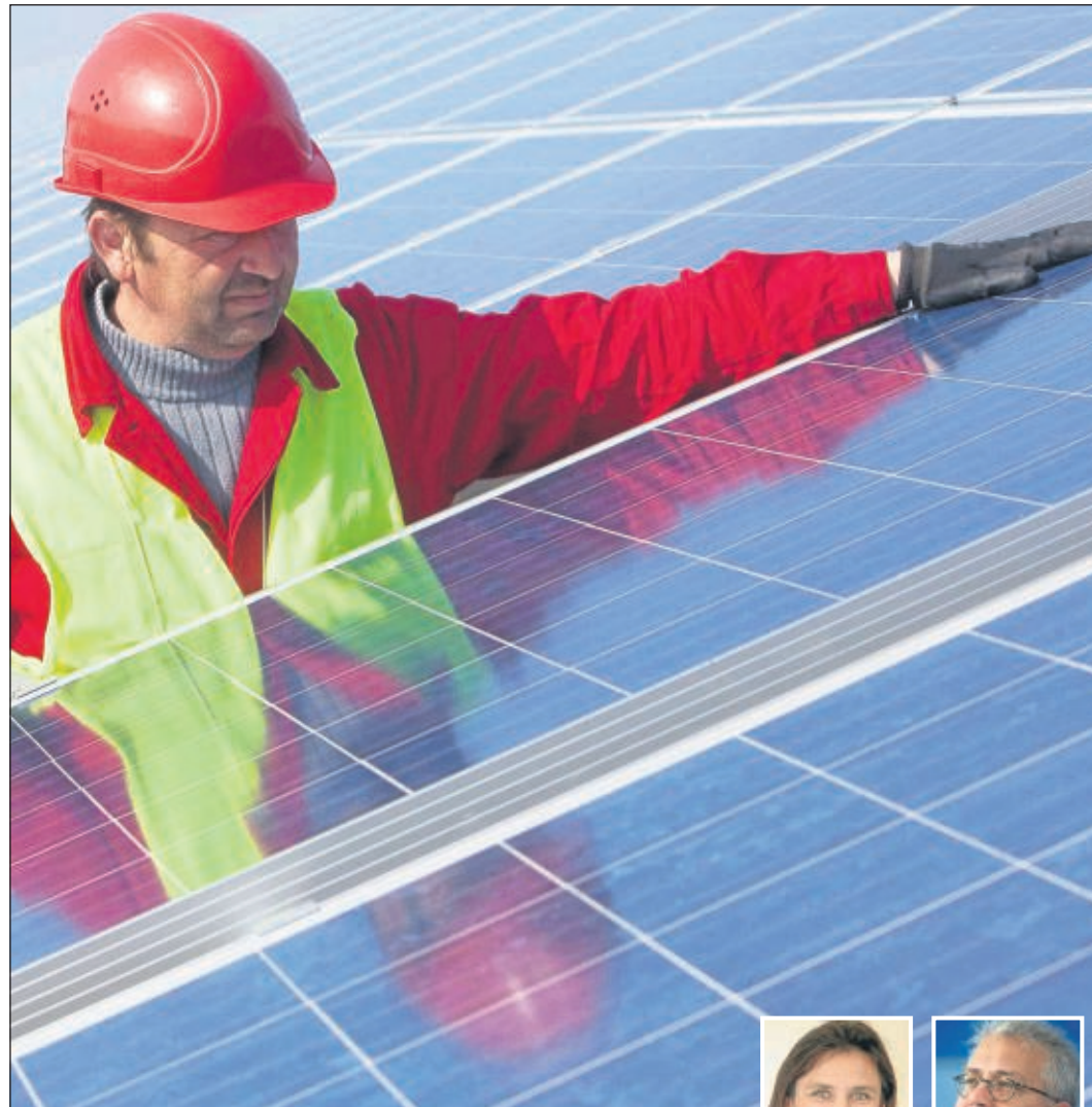
Monteur auf einem Solarstrom-Dach: Hessens Häuser lassen sich jetzt im Internet auf Eignung zur Sonnennutzung checken. Foto: dpa
